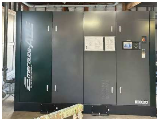
コンプレッサー 250KW×2台 ドライヤー・フィルター・タンク8m 3
