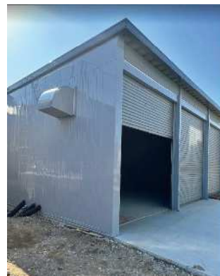
コンプレッサー建屋
