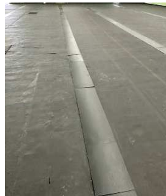
鉄板敷き(アングル止め)
